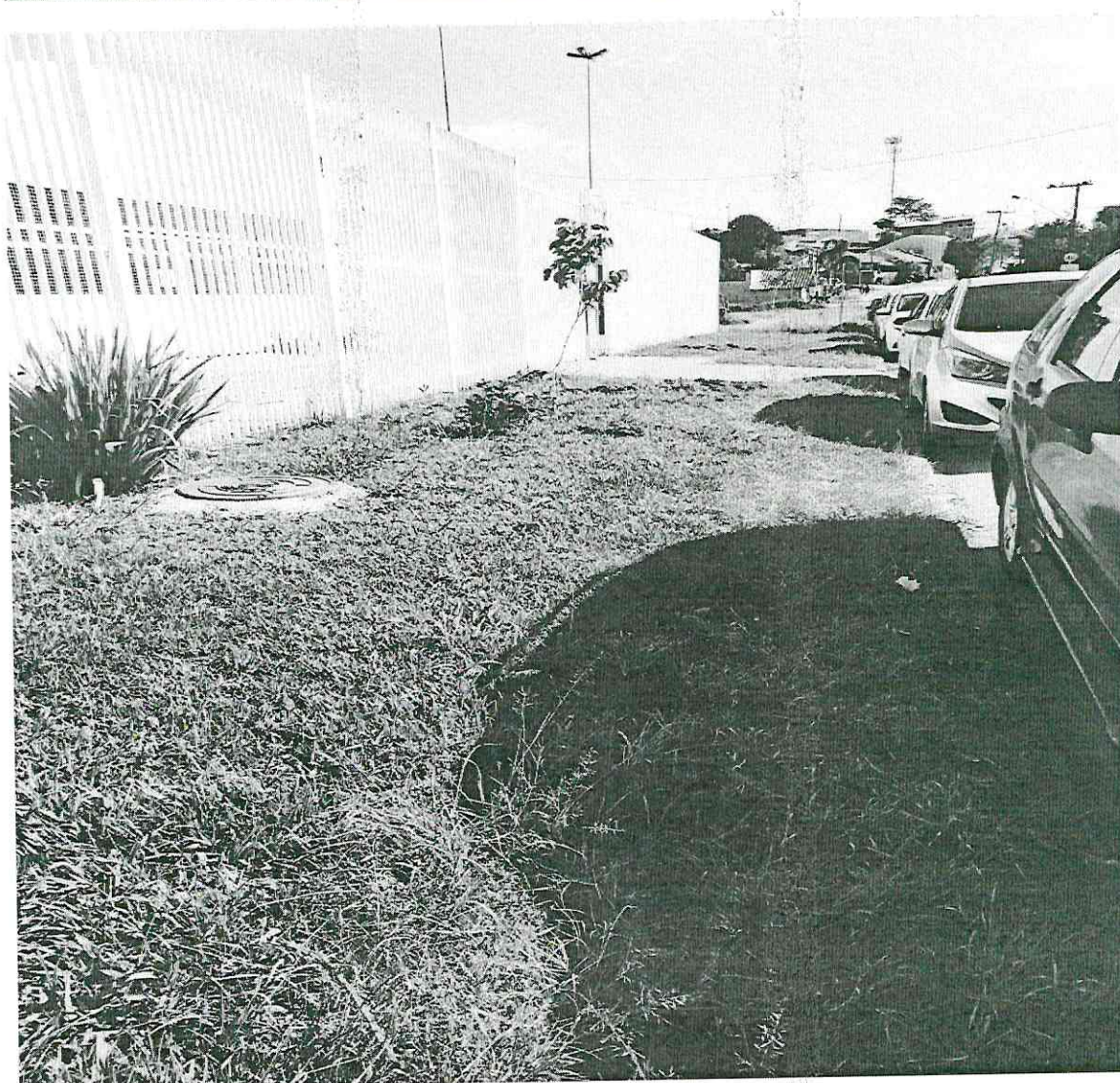
RUA RIO TIETÊ PRÓXIMO AO Nº 311 NO BAIRRO IGUAÇU.
